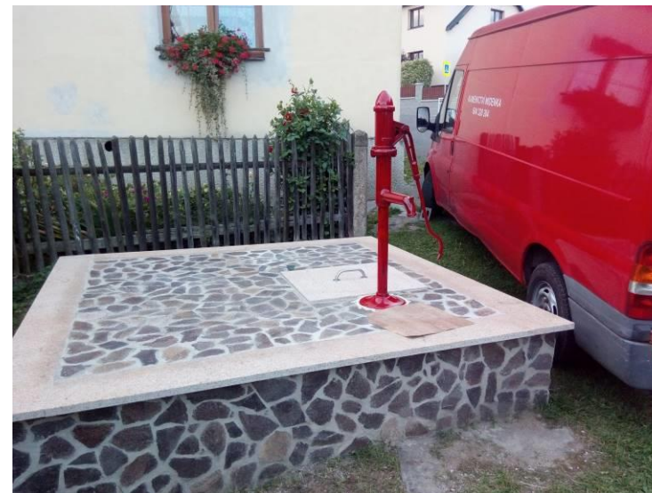
Firma Widenka krásně opravila obecní studnu u transformátoru v dolní části Budišovic.
