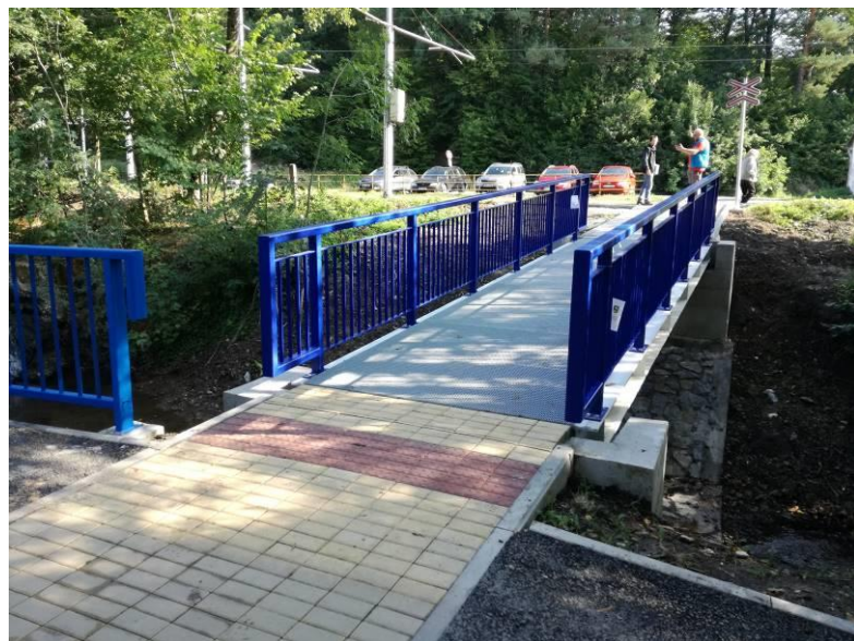
Mostek u tramvajové zastávky v Zátíší po rekonstrukci.
