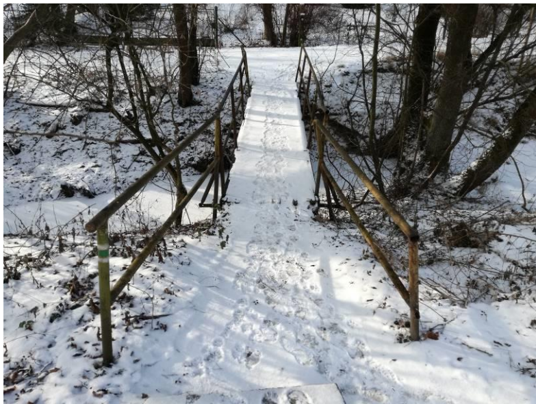
Mostek u tramvajové zastávky v Zátíší před rekonstrukcí.
