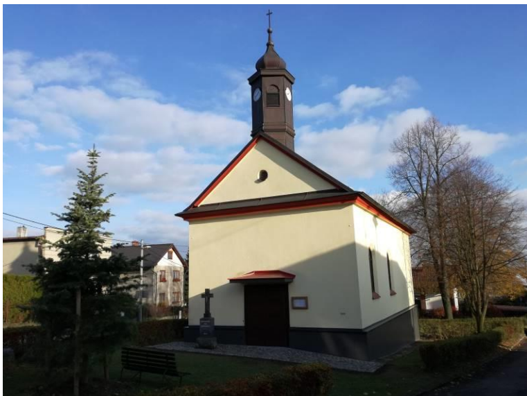
Máme obrovskou radost z opravené kaple svatého Víta.
